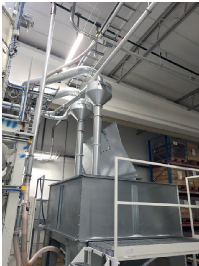
"Closed Loop" – gör att vi kan återvinna kantspill direkt.
